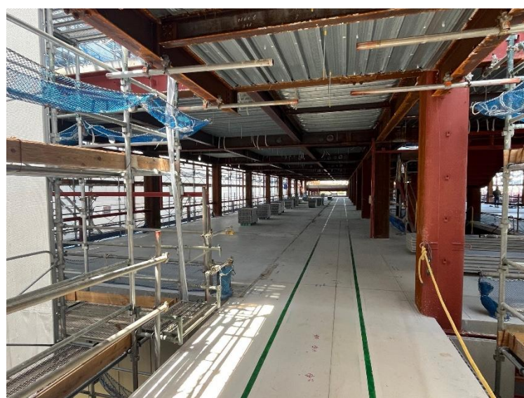
2 階部分 東側から西側へ
